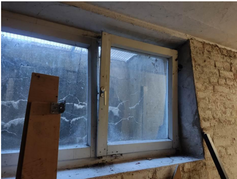
Abbildung 11: Kellerfenster und Lichtschacht (mit Metallgitter abgedeckt).
