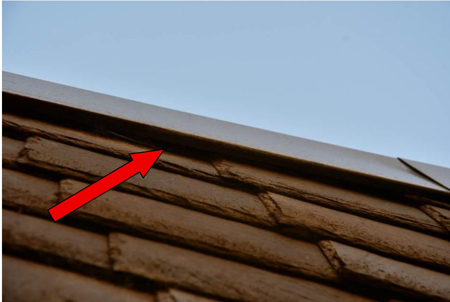
Abbildung 8: Quartierpotenzial für spaltenbewohnende Fledermäuse und Brutplatzpotenzial für Gebäudebrüter hinter der Blech – Attika am oberen Ende der verschieferten Außenfassade im Osten und Westen des Gebäudes.
