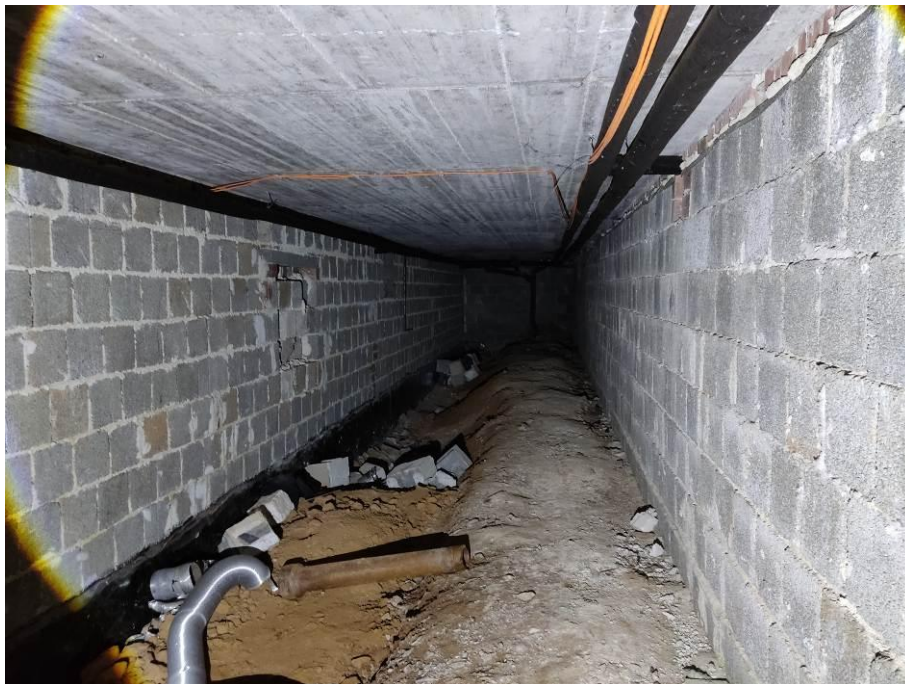
Abbildung 12: Ehemaliger Bunker unterhalb eines Gebäudeteils.
